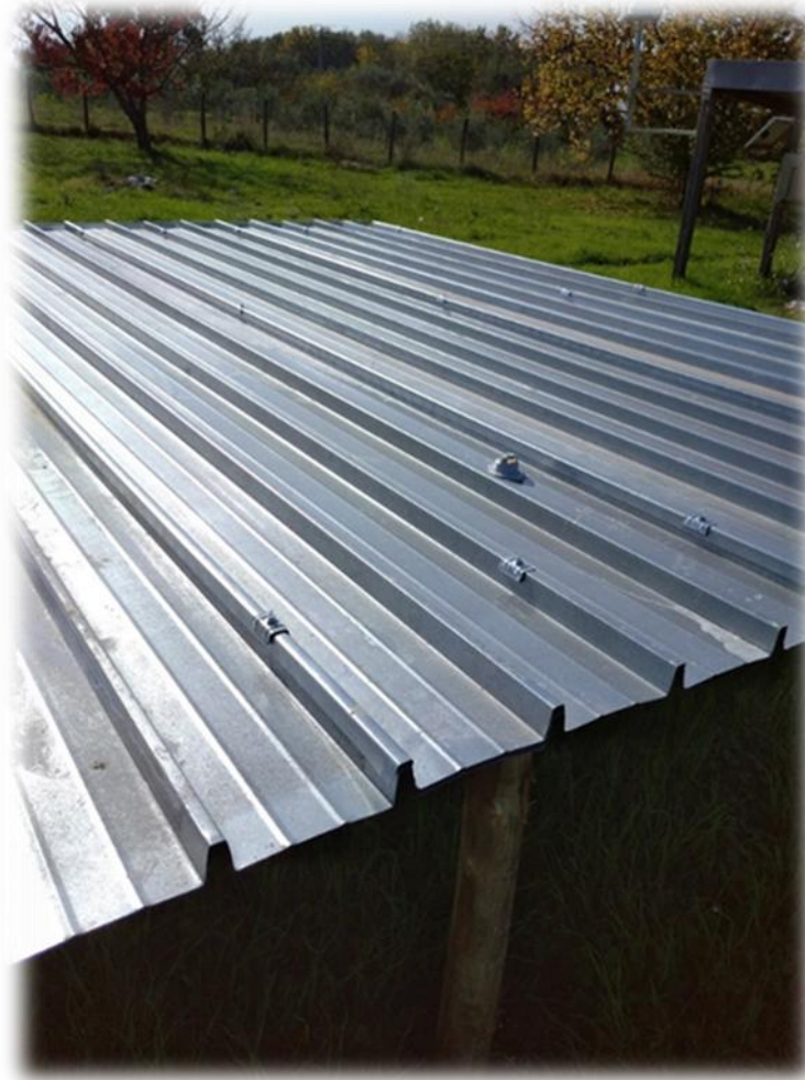
Figura 7. El techo de acero (benchmark).
