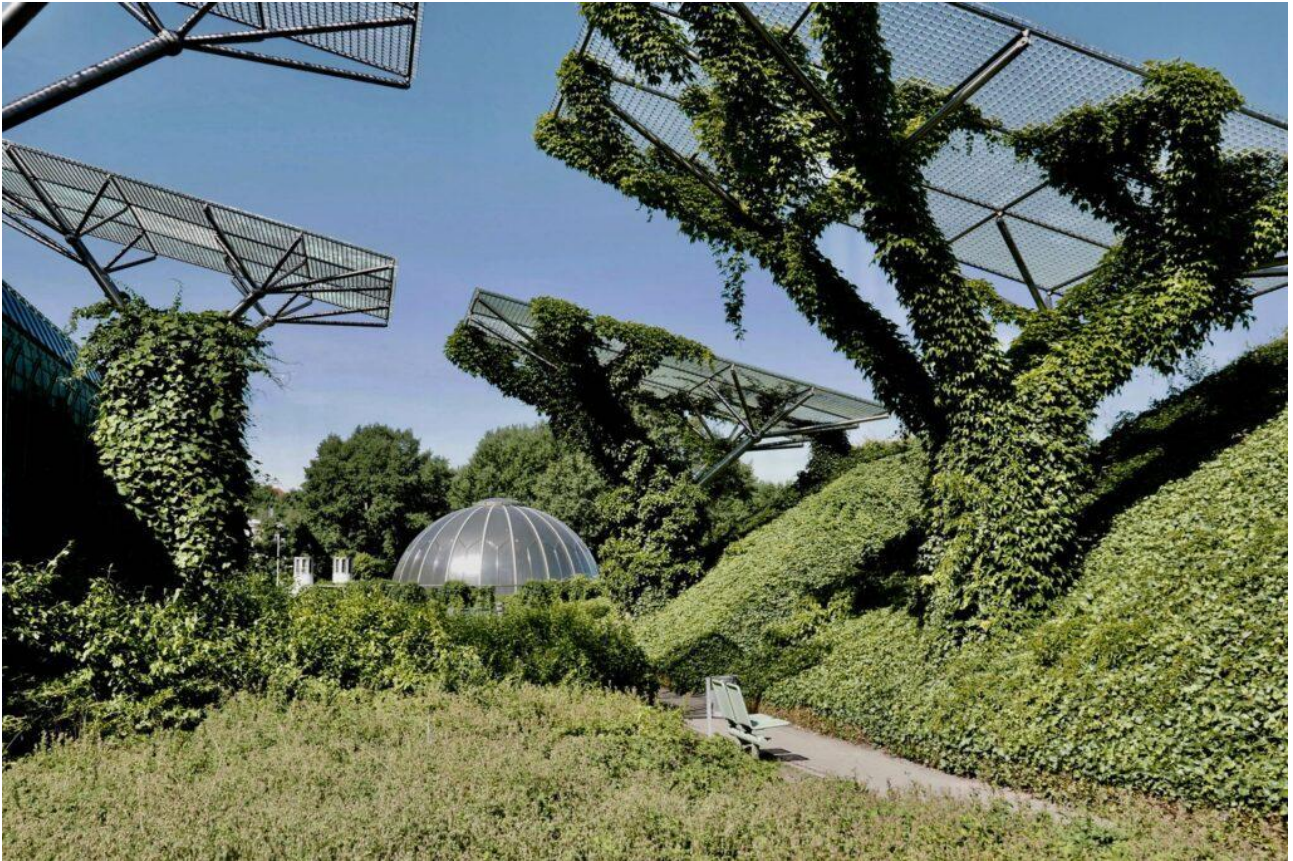
Figura 13: Cubierta verde en Varsovia, Polonia
